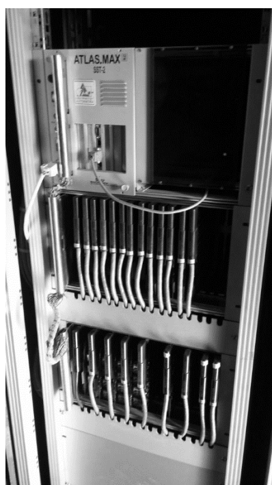
Slika 6. Daljinske stanice tipa ATLAS MAX SST i VF uredaj PET 300.
